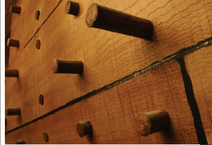
الأوتاد الخشبية (شجرة المسامير أو TRUNNELS) ما أن يتم طرفها من خلال ثقب تم حفره، فإن الوتد يتمدد بفعل الرطوبة، ويُشكّل رابطة دائمة وحائل مائي.
